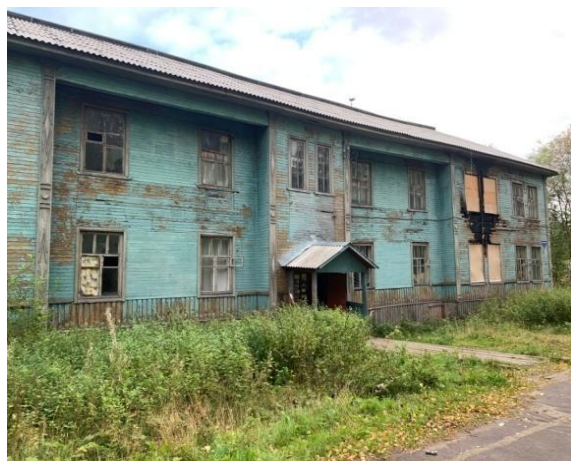
Жилой дом по адресу: ул. Лесотехническая, д. 3, г. Архангельск, 15.09.2021
