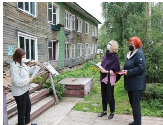
Выезд Уполномоченного с проверкой по жалобе К в связи со сходом со свай многоквартирного дома (г. Архангельск, наб. Северной Двины, д. 32, корп. 10)
